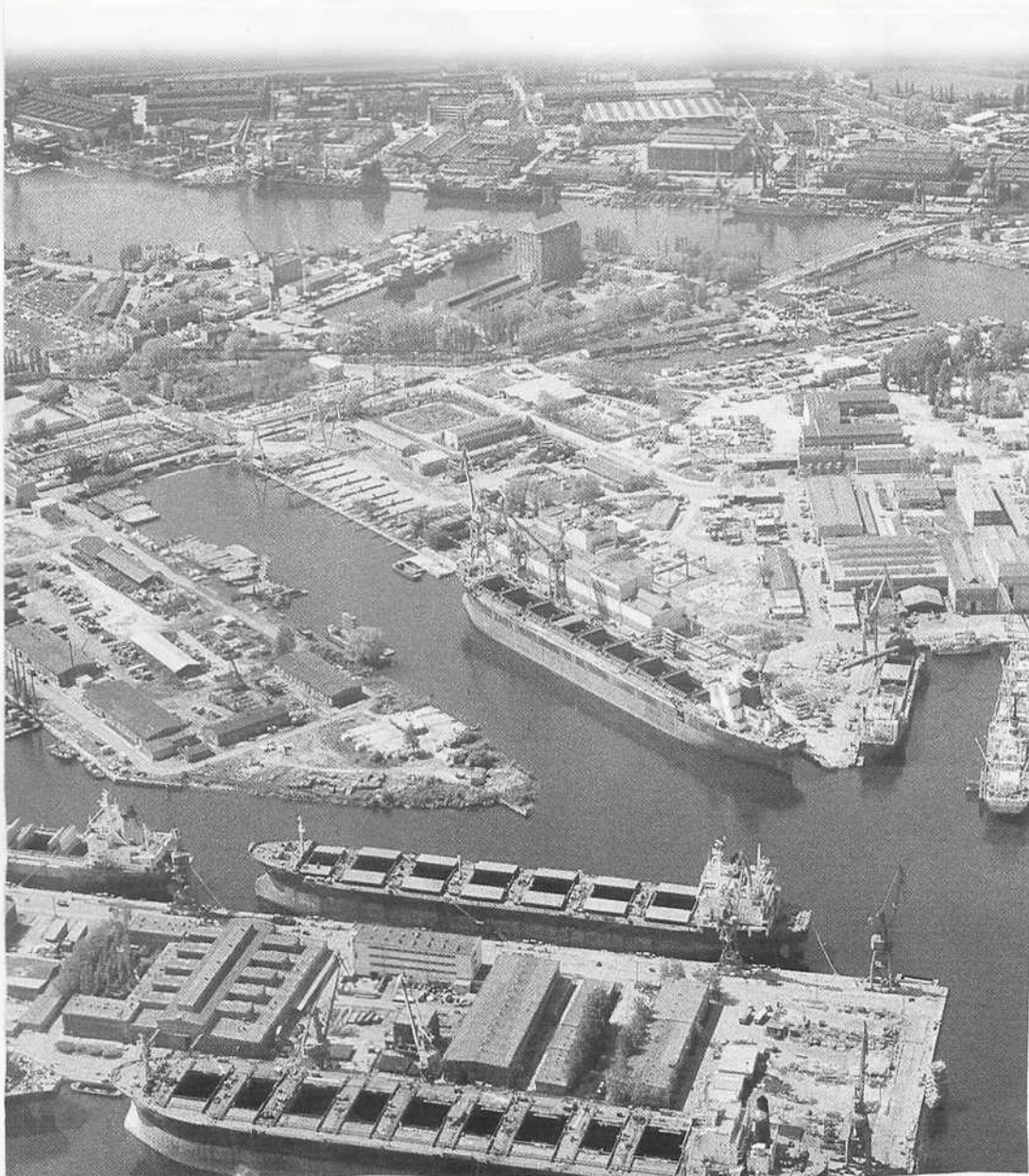
Stocznia Gdańska - widok z lotu ptaka.
