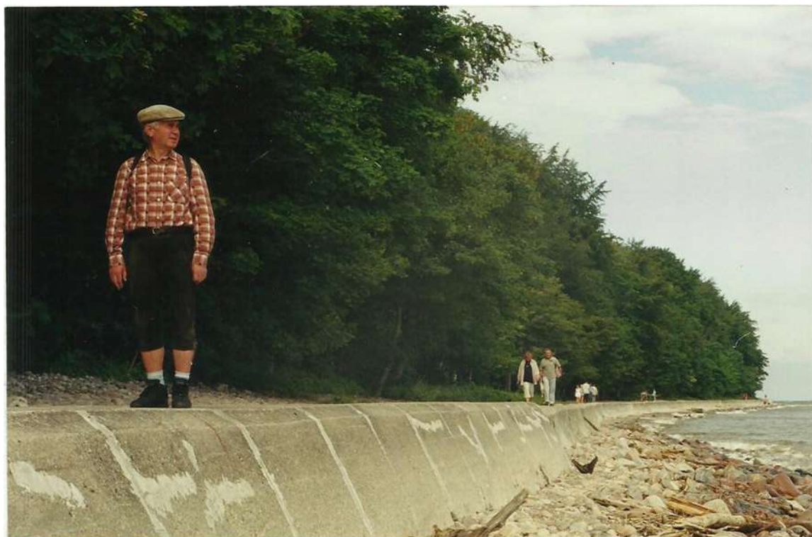
Antos' Litwin na opasce betonowej chroniącej brzeg przy- lądka Rozewie.
