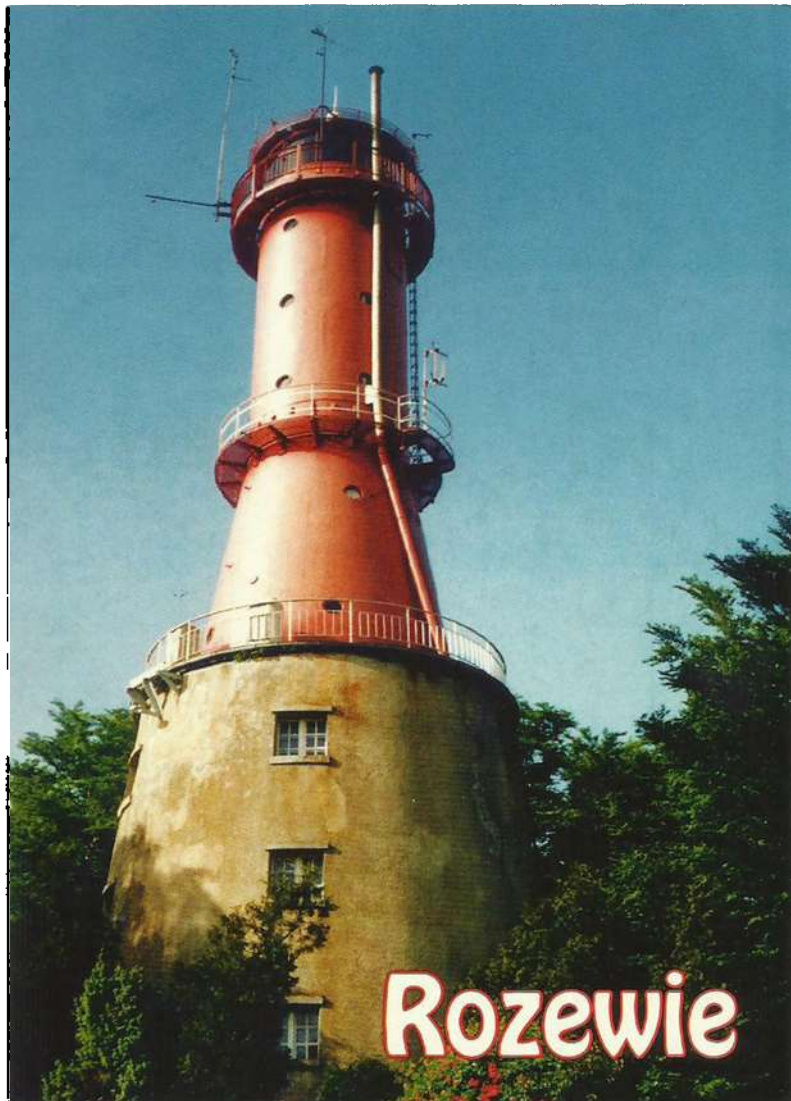
Radiolatarnia morska Rozewie im. Stefana Żeromskiego.
