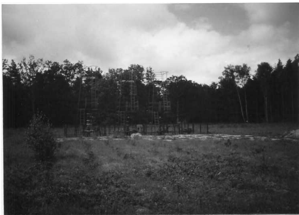
Dębki. Ujęcie gazu.
